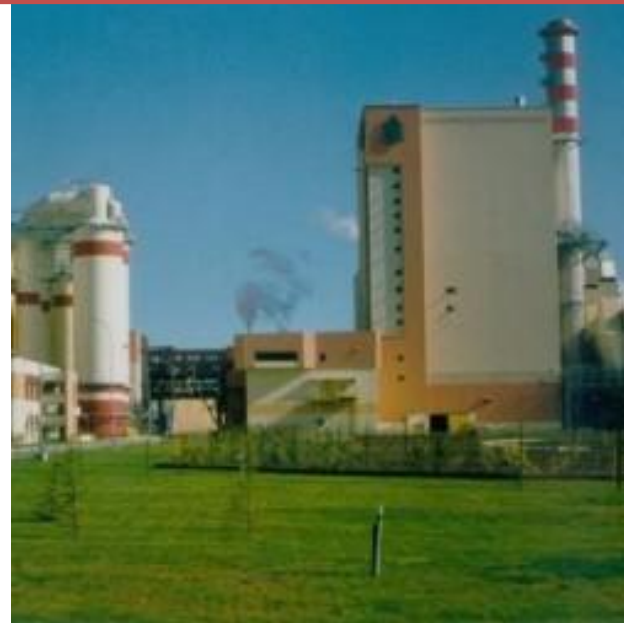
Planta de Celulosa Horcones de Arauco
